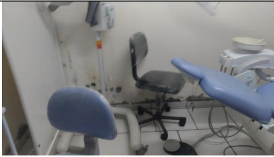
Parede da sala de odontologia onde será realizado tratamento e revestimento cerâmico.
