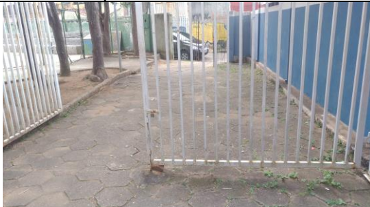
Gradil que receberá pintura
