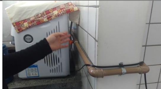
Tubulações a serem embutidas na parede.
