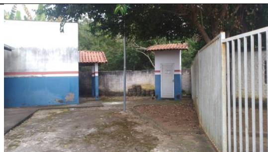
Área externa a receber pintura.
