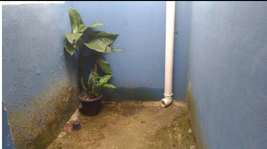
Área do fosso a ser tratada e instalada grelha de drenagem.
