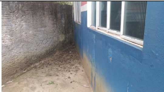
Área externa da sala de agentes onde será instalado o ralo.
