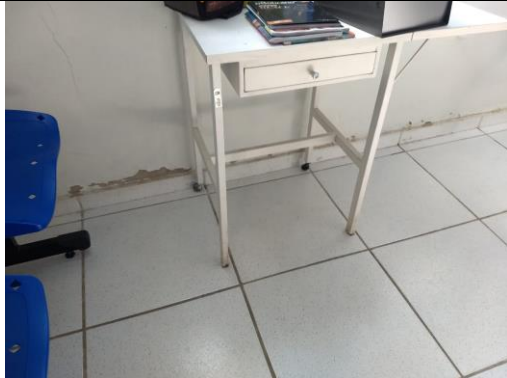
Paredes que serão tratadas até 0,5 m.
