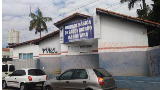
Fachada onde será colocada as grades de jardim e que receberá pintura.
